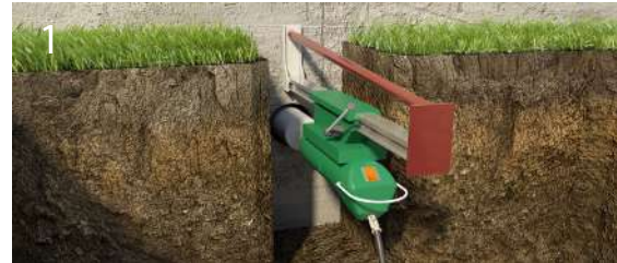
Алмазное сверление фундамента для прокладки канализационного трубопровода.
